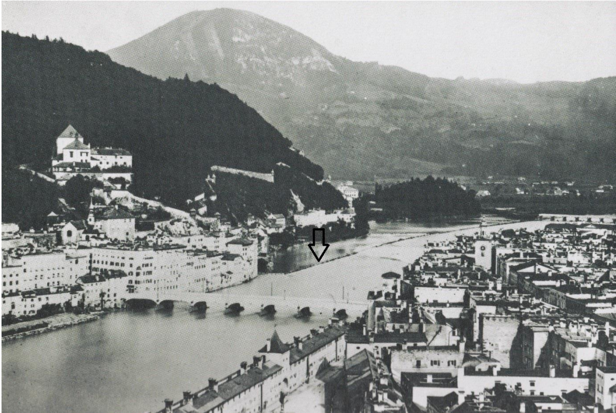
Abb. 1: Blick vom Mönchsberg in Richtung Äußerer Stein, vor 1863 (Längswerke siehe Pfeil)
